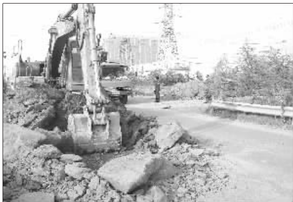
渣土堵路 快报记者 李绍富 摄
