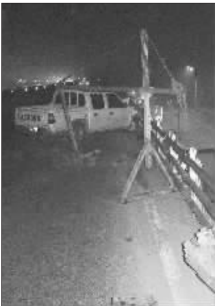
卡车撞断了吊篮固定处
