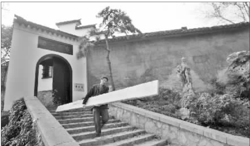
工人们正在搬运修楼用的木料
