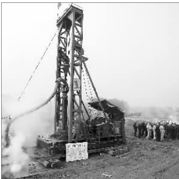
南京南站桩机工程开工现场 快报记者 顾炜 摄
