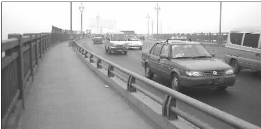
大桥快车道和慢车道之间装起了护栏
