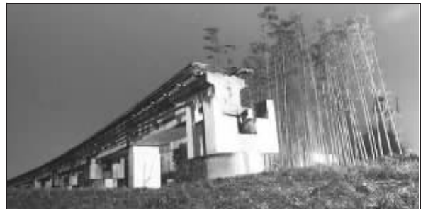
原用于西南交大研制的磁悬浮列车试验的轨道被敲断
