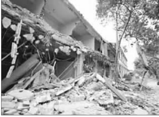
房屋被拆现场一片狼藉
