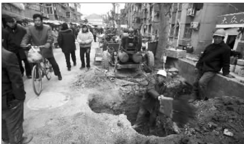
施工人员正在忙着修路 快报记者 顾炜 摄
