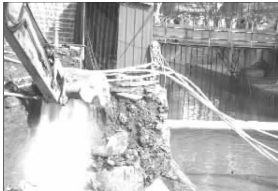
挖掘机爪头压住水柱 快报记者 薛林 摄
