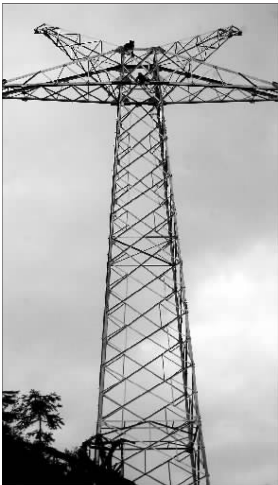
江苏电力为灾区竖起的新铁塔。 快报记者 顾炜 摄
