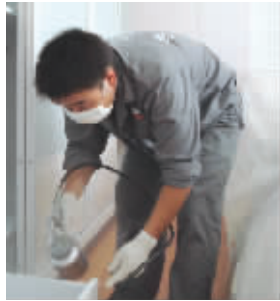
技术人员正在进行污染治理
