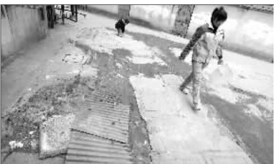
黄鹂新村居民楼前化粪池漫溢。 快报记者 唐伟超 摄
