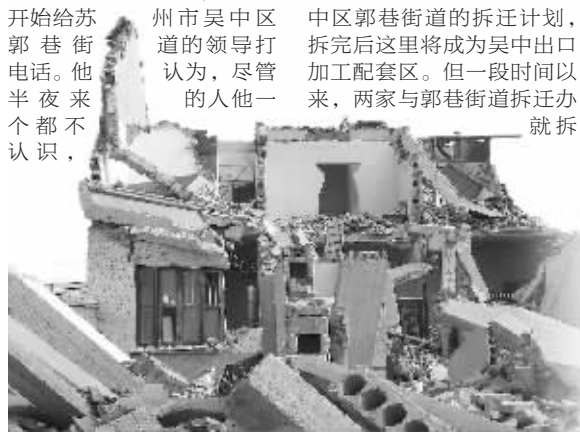
沈建方家被拆的房子
