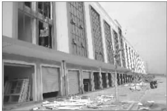
这栋4层楼房刚建好就要拆
