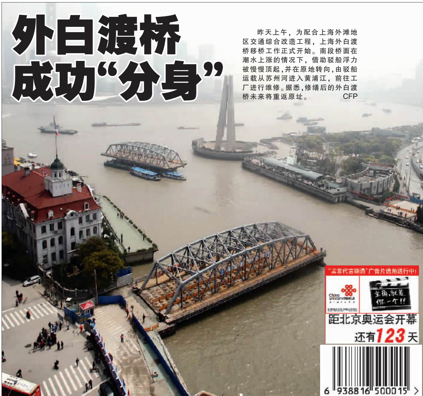
4月6日，在拖船帮助下，驳船运载着上海外白渡桥南段桥面驶往黄浦江。
