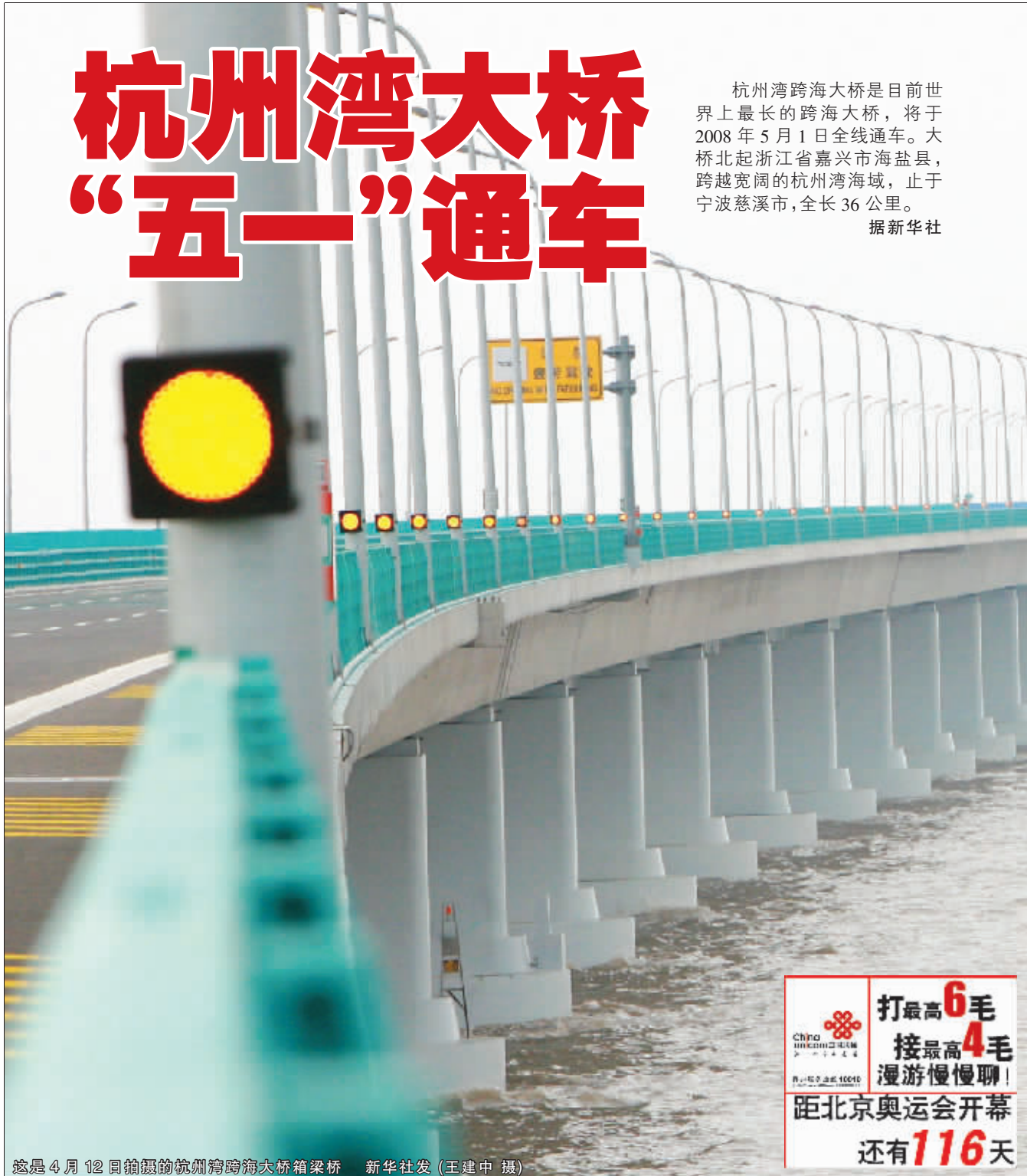
这是4月12日拍摄的杭州湾跨海大桥箱梁桥 新华社发(王建中摄)
