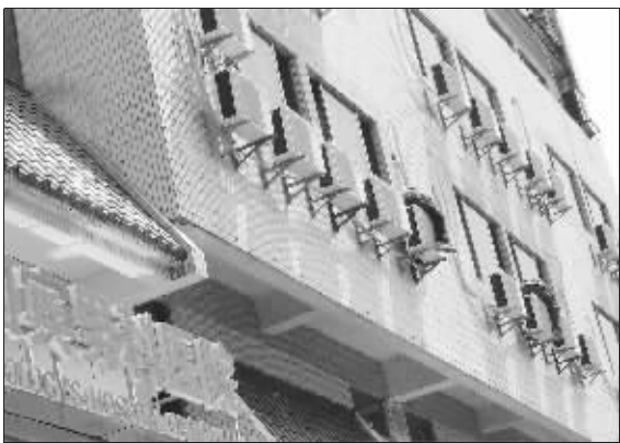
医院已将朝向居民大院的空调外机移到临街外立面
