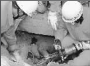
用液压钳剪断周围的钢筋
