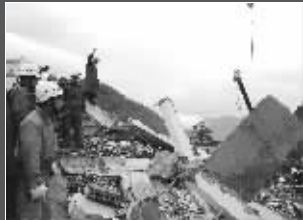
起吊压在晏鹏上方的楼板
