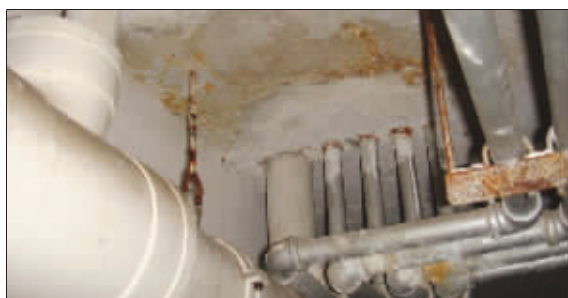
车库顶部的水管处腐烂发霉
