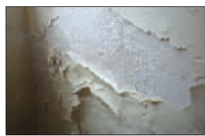
严重脱皮发霉的墙面
