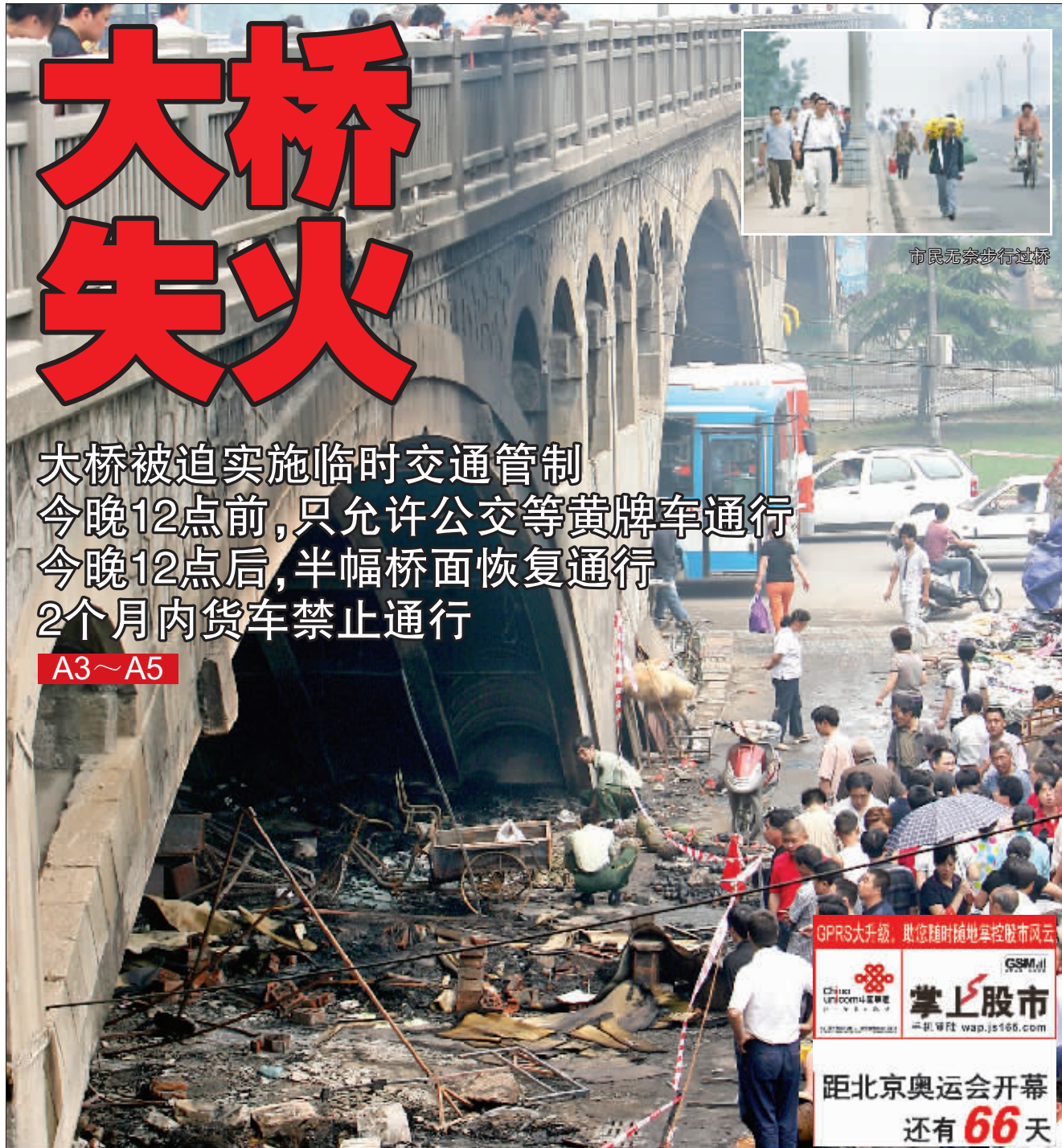
昨天凌晨3点左右,南京长江大桥南侧桥洞内的小商品市场燃起了大火,使大桥通行受到严重影响。 快报记者 施向辉 摄
