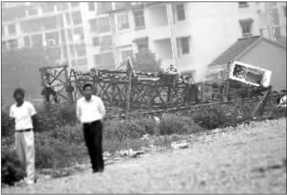
拆除中,塔吊齐腰折断 快报记者 唐伟超 摄
