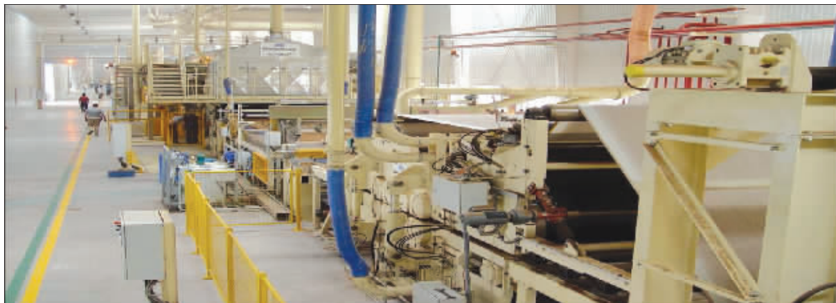
大亚木业刨花板生产线实景
