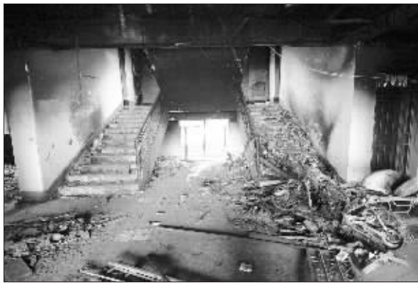
被破坏的县政府大楼大厅
