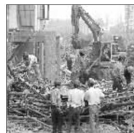
工地正在清理倒塌的脚手架 快报记者 薛林 摄
