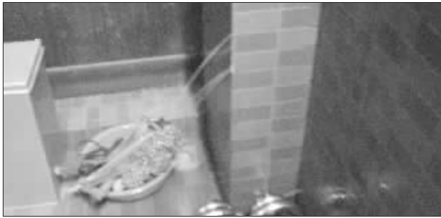
瓷砖缝隙在往外喷水 陈女士提供
