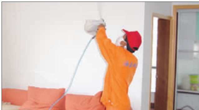
海泰纳米的工人正在进行污染治理
