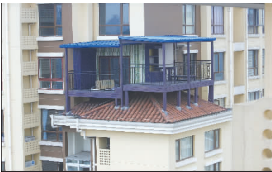
32楼的业主竟在窗外搭了一个大露台
