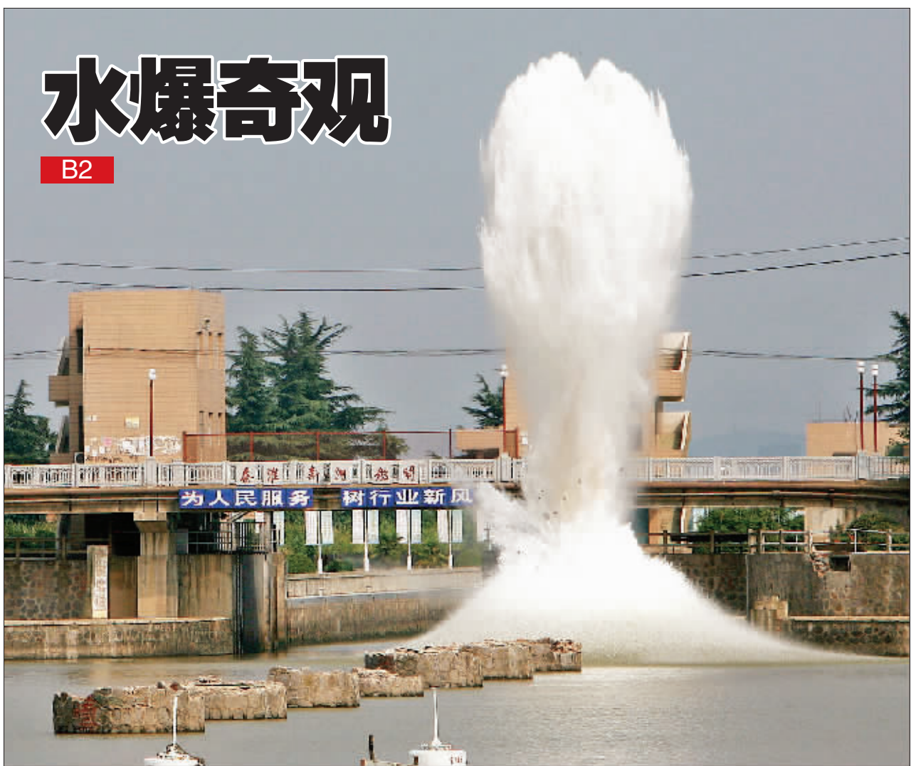
为确保附近民居和油库的安全,南京市昨天首次采用“水压式爆破”的方式爆破了秦淮河上的八个老靠船墩。威力巨大的爆破激起了几十米高的水柱,但对周边的民居和油库没有丝毫影响。专家介绍,“水压式爆破”主要用于爆破可充水的建筑物。 快报记者 施向辉 摄
