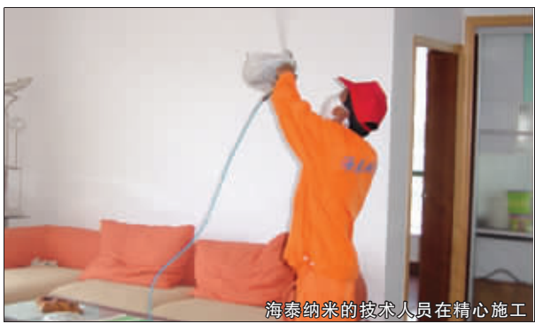
海泰纳米的技术人员在精心施工
