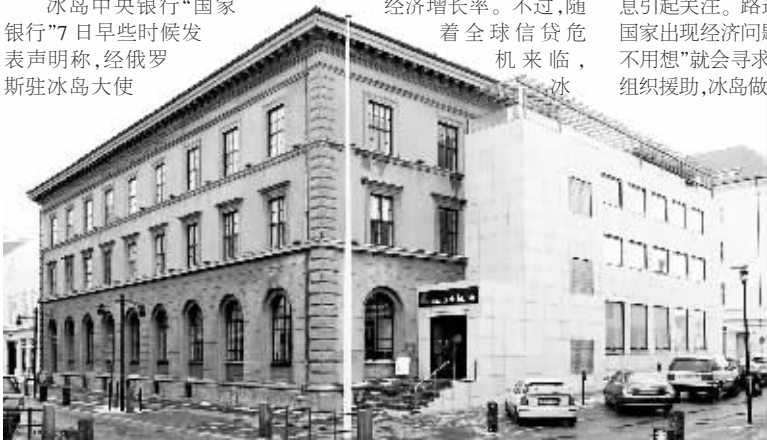
冰岛第二大银行Landsbanki位于首都雷克雅未克的总部大楼。新华社/法新
