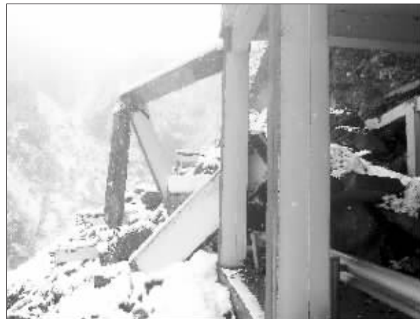
因受暴雪影响,川藏公路然乌沟段发生雪崩,并引发山体垮塌。 新华社记者 叶辉 摄
