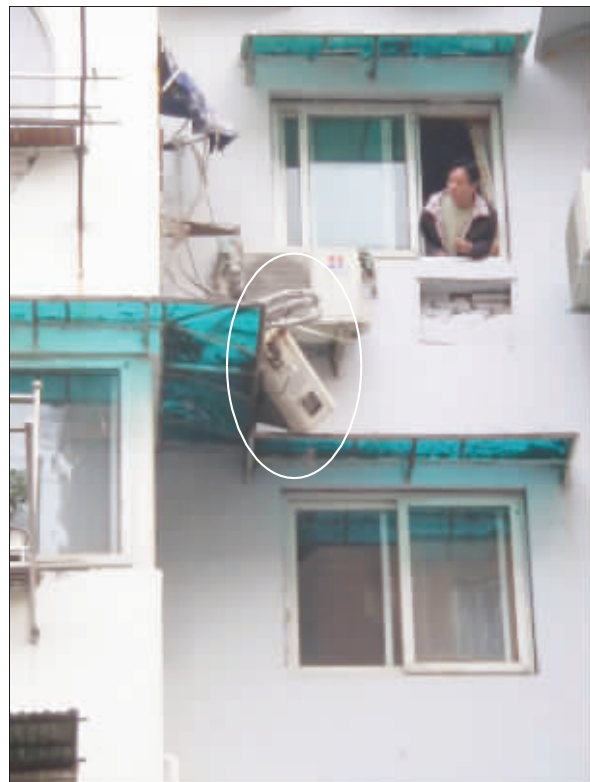
空调外机被二楼遮阳篷托住
