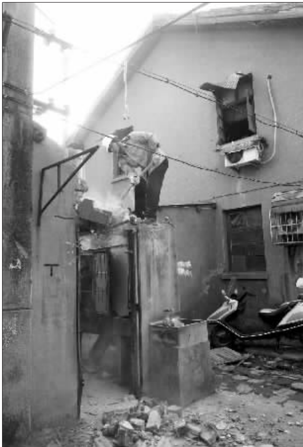
工作人员正在拆除三条巷内的违建
