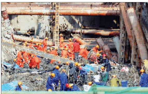
11月18日,工程人员在清理淤泥。新华社记者黄深钢摄
