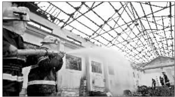
厂房被烧光,所幸损失不大 快报记者 施向辉 摄
