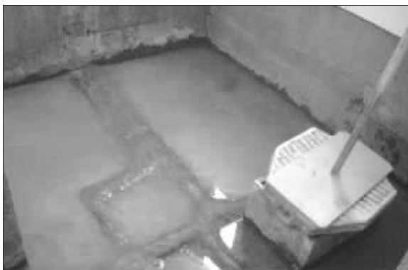
卫生间闭水实验一丝不苟
