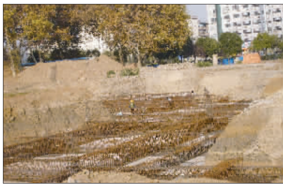
工人们正在拆除钢筋构架
