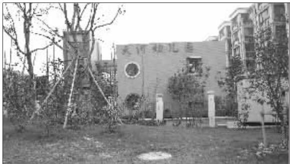
发生事故的天河幼儿园
