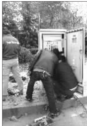
抢修人员维修交通信号控制机
