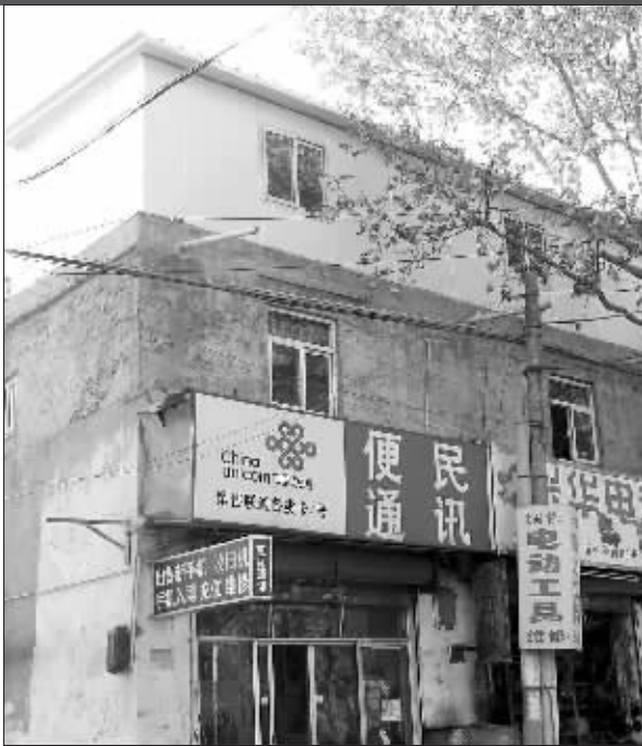
随处可见在房屋上加盖的违建
