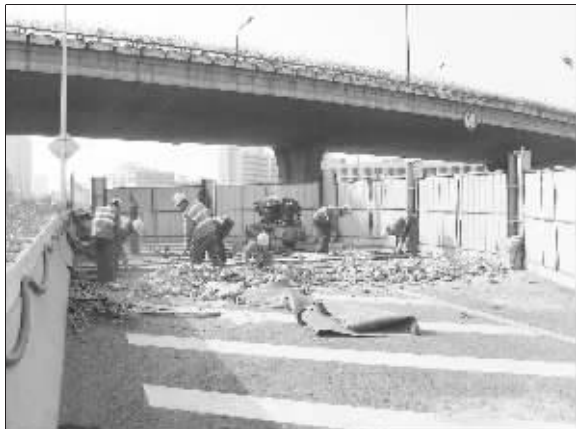
工人们正在施工 快报记者 赵守诚 摄
