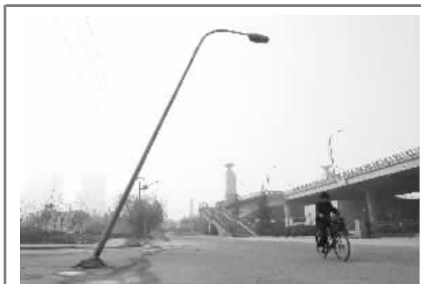
昨天,在郑和中路附近,一根大约5米高的路灯杆向路中间倾斜,不少路过的市民纷纷绕行,生怕灯杆会突然倒下来砸伤自己。 快报记者 唐伟超 摄
