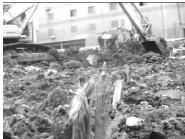
地下露出的圆形木桩 快报记者 薛林 摄
