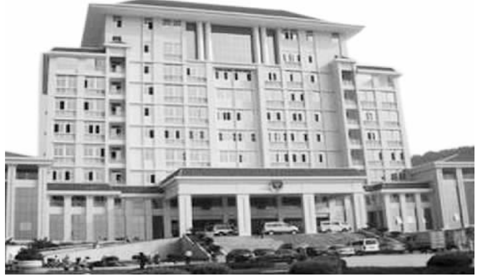
韶关市公安局新办公大楼
