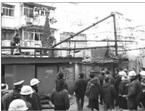
执法人员正在拆除烟囱
