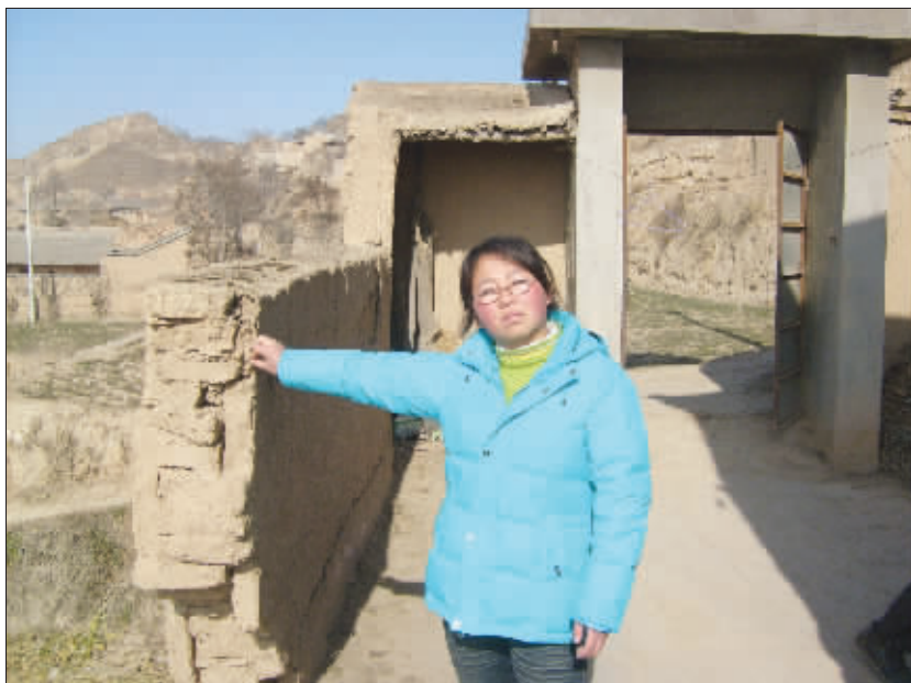
王喜梅家在地震中倒下的围墙至今也没有修复 快报特派记者 王冕 摄
