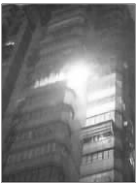
着火的16楼阳台
