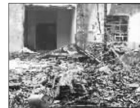
烧毁的厂房间 王彪 摄
