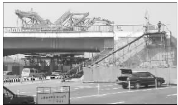
红星大桥拆除现场
